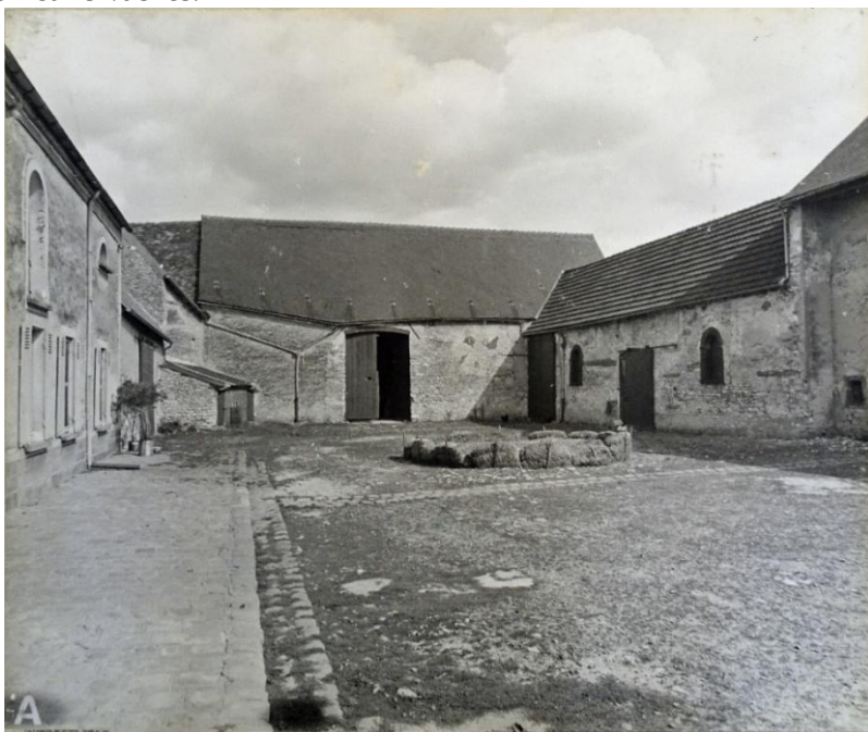
La ferme du Coulon, façade sur cour. Document non daté. ADE – 10FI/65.
