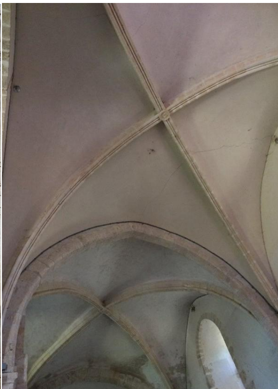
Figure 5 : vue des voûtes
